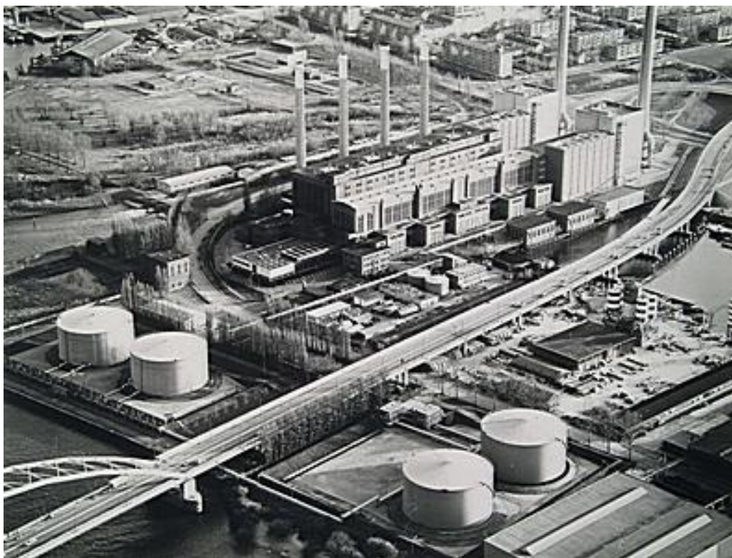
De Merwedecentrale op de Kerkeplaat bij de Eerste Merwedehaven (bron: beeldbank regionaalarchief Dordrecht)
